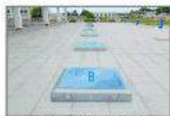
全专业样板引路
